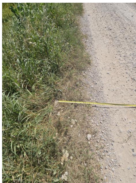
Zdj. 4 – istniejąca nawierzchnia – zasypane i zarośnięte krawędzie i obrzeża
